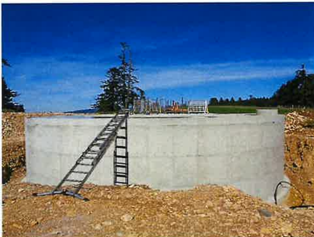
Exemple de citerne en construction
